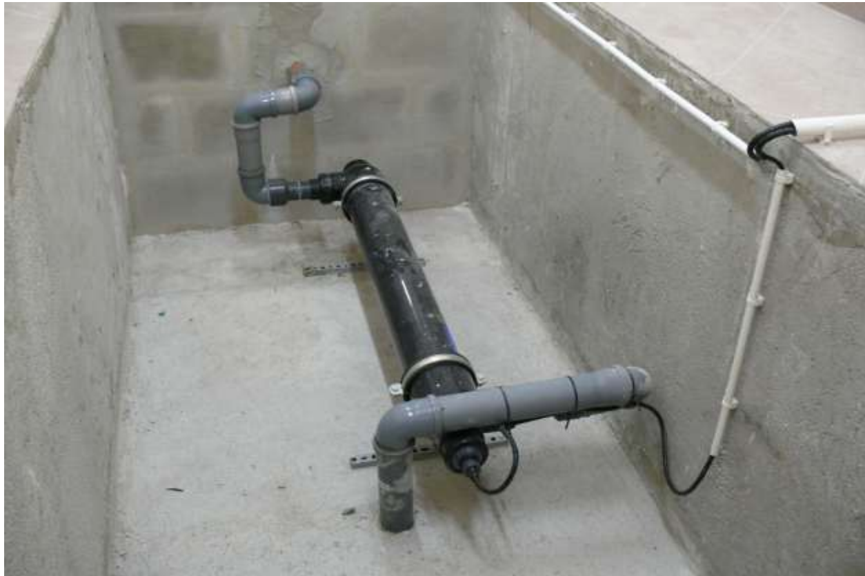
System dezynfekcji wody zawierający lampę UV
